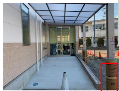
(写真左) 2月17日 (写真右) 3月2日 支柱に補強されているのが見えます。
